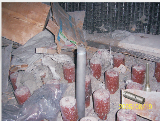
炉膛内部热电偶安装 图(四)
