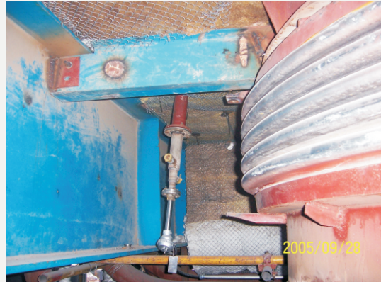
炉底布风板上水冷套管热电偶安装 图(二)
