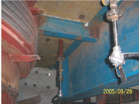
炉底布风板上水冷套管热电偶安装 图(一)
